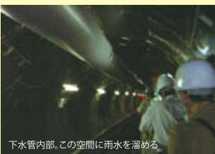
下水管内部。この空間に雨水を溜める
