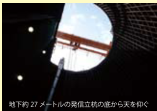
地下約27メートルの発信立坑の底から天を仰ぐ
